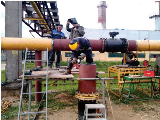
Планом производства работ предусматривались следующие виды работ: сварочные работы на газопроводе высокого давления диаметром 400 мм со снижением давления, снижение давления на участке к ПГРП-2 и ПГРП -3 в г. Бобруйске, контроль за работой ГРП-22,25, ШРП-30, 33 в г. Бобруйске., ограничение пользования газом 14 промышленных потребителей. Сварочные работы, ввиду их сложности, выполнялись одновременно в 3-х местах 6-тью сварочными бригадами в составе:
