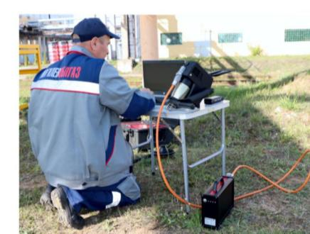
Опыт использования привода показывает, что в 80% случаев можно восстановить работоспособность арматуры с помощью нескольких циклов закрытия/открытия.
